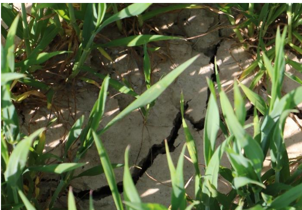
Trockenrisse durchbrechen „Lehmkruste“ und fördern den Luftaustausch im Boden
